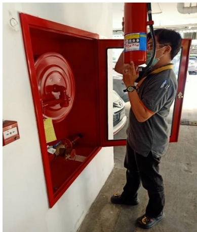
ภาพที่ 11 อุปกรณ์อัคคีภัยและการตรวจสอบอุปกรณ์อัคคีภัยประจำเดือน
