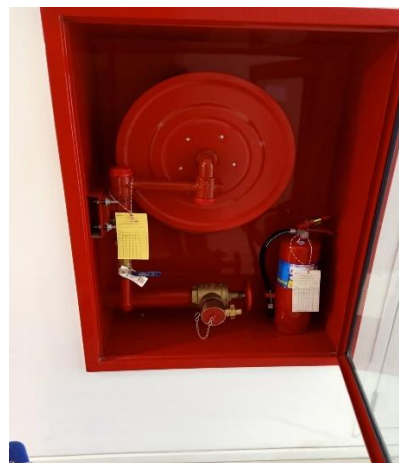
ภาพที่ 11 อุปกรณ์อัคคีภัยและการตรวจสอบอุปกรณ์อัคคีภัยประจำเดือน
