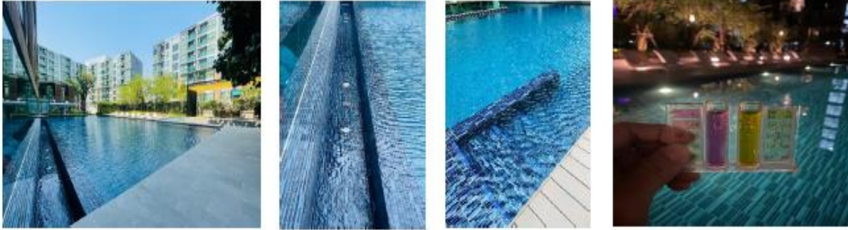
ภาพที่ 15 รางระบายน้ำสรวายน้ำ,บันไดขึ้น-ลง สรวายน้ำ และ การวัดค่า CL-pH
